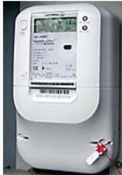
Boxen med GPRS-Sändare och PLC System
